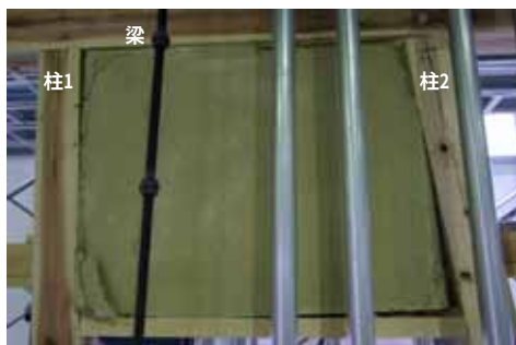
図N_16 中塗り側 1/8.6rad 垂れ壁ひび割れの拡大
