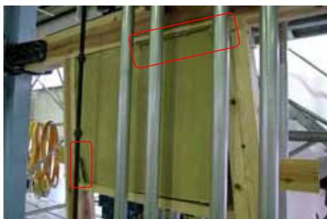
図N_12 中塗り側 1/10rad ひび割れ拡大
