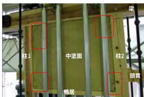
図N_5 中塗り側 1/30rad 隅角部ひび割れの拡大
