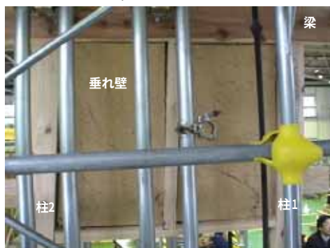
図N_11 裏返し塗り側 1/12rad ひび割れ拡大
