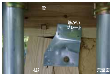
図 K_9 試験終了後 柱2側 筋かいプレートの変形
