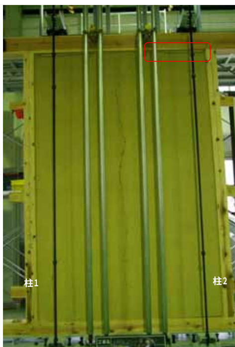
図1.6 中塗側 1/75rad 中央間柱のひび割れ拡大、隅角部圧壊の拡大
