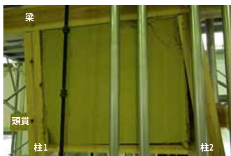
図M_15 中塗り側 最終加力時1/8.6rad ひび割れ拡大
