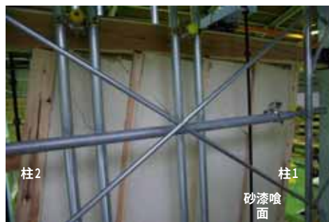
図I.13 砂漆喰側 1/7.5rad せん断ひび割れ
