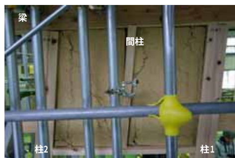
図M_16 裏返し塗り側 最終加力時1/8.6rad ひび割れ拡大
