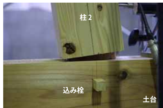
写真 3.5.14 1/18rad 柱2 ほとりの折損
