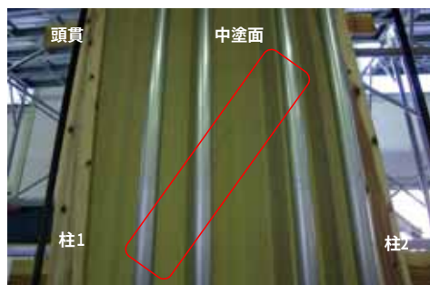
図 K_6 中塗り側 1/25rad セン断ひび割れ
