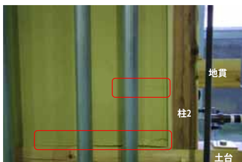
図 K_3 中塗側 1/50rad ちりきれ、隅角部圧壊が拡大、地貫に沿ったひび割れ
