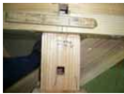
図 D.1 荒壁側
