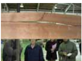
図 H. 貫の割裂
