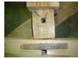
図 D.10 荒壁側
