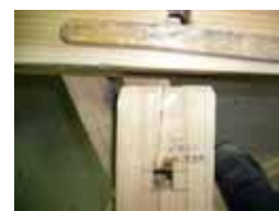
図 D.2 荒壁側
