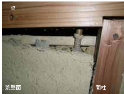
图 F-1.6 荒壁側 最終引込
