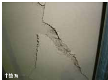
图 F-1.5 中塗側 最終引込
