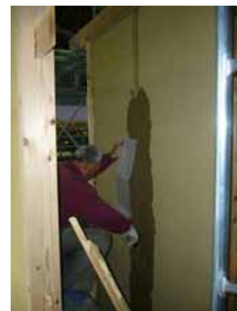
写真 2.2 寒冷紗の塗付け
