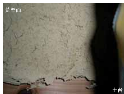
图 F-1.8 荒壁側 最終引込
