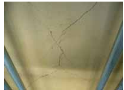
写真 4.3.2 柱-土台隅角部の圧縮
