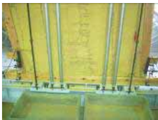
図 A-2.11 荒壁側
