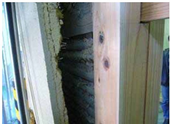
图 a-3.6 中塗側 最終引込
