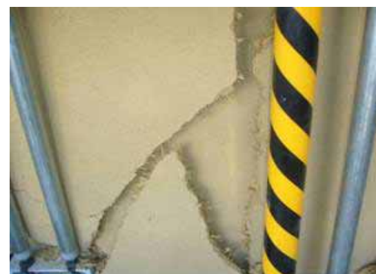
图 a-2.8 中塗側 最終引込
