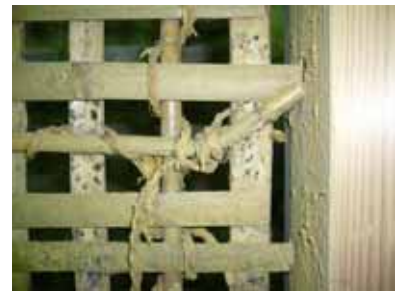
写真 4.3.5 割り竹の軸組へのめり込み
