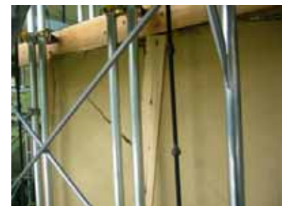
写真 4.3.4 Type-C せん断亀裂
