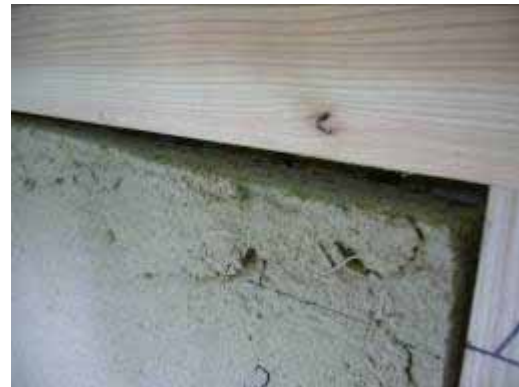
写真 3.3.3 B-3 厚み方向の膨らみ
