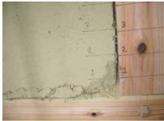
图 a-1.6 中塗側 最終引込
