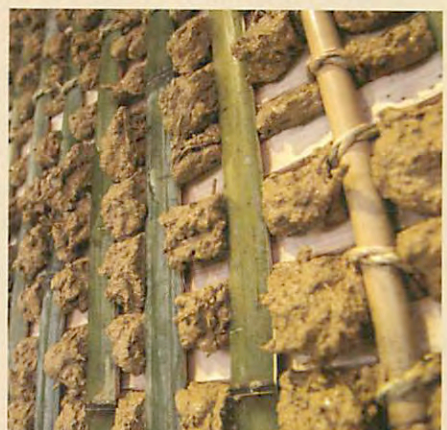
▲ 試験体 B (地域型) は荒壁が裏側まではみ出す
