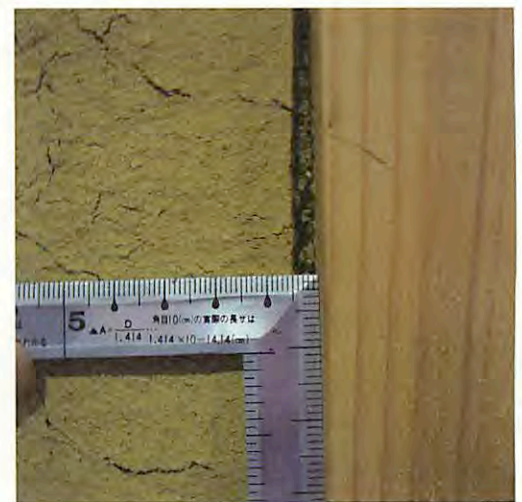
▲裏返し塗りと軸組の間に発生した乾燥収縮
