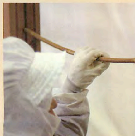
▲ 間渡し竹の径が太いと曲げて差込穴の奥まで入れることができない。
